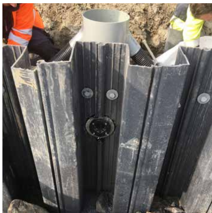
Installatie van het JLD Filter bij kunststof damwand te Vlissingen..
