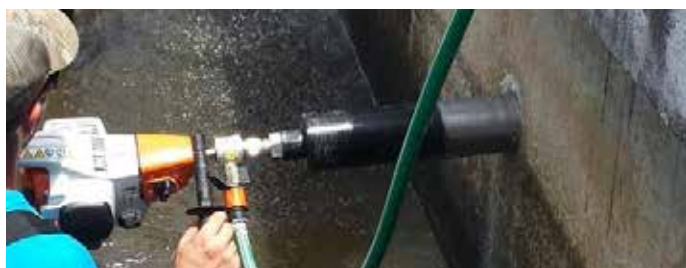
Het uitboren van de filters in de wand.
