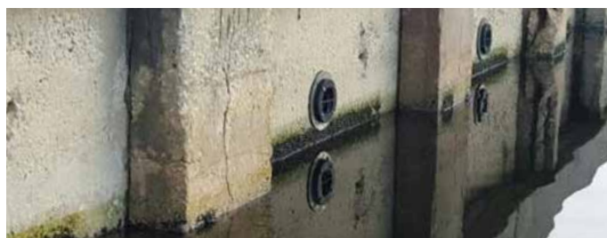
Installeer de filters zo dat het centrum van het filter 10 cm tot 15 cm boven de gemiddelde waterlijn of grondlijn is.
