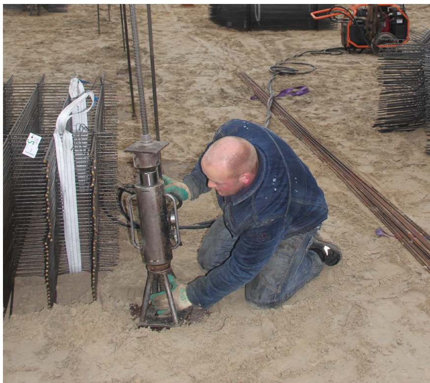
4. Afspannen van de JLD-Klapankers met een vijzel.
