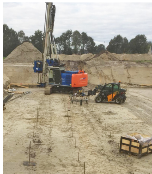
2. Installeren van de JLD-Klapankers.
