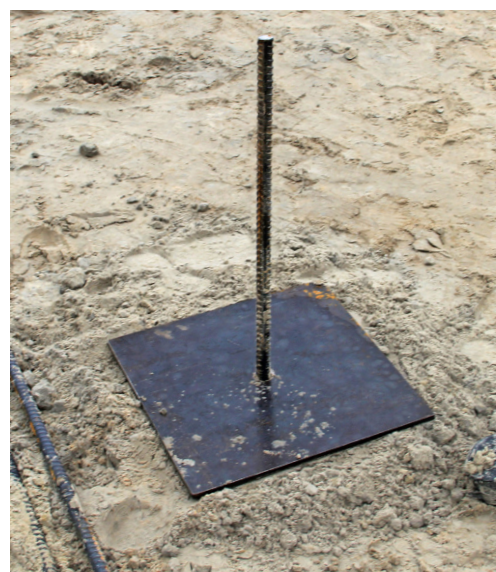
3. Plaatsen van de afspanplaat,
