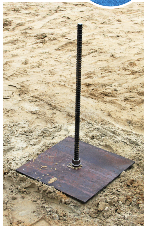
5. Op voorspanning en geborgd met een moer.
