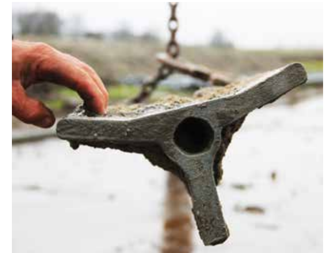
Het LDE (vin) element brengt de dwarskracht over naar de bodem.
