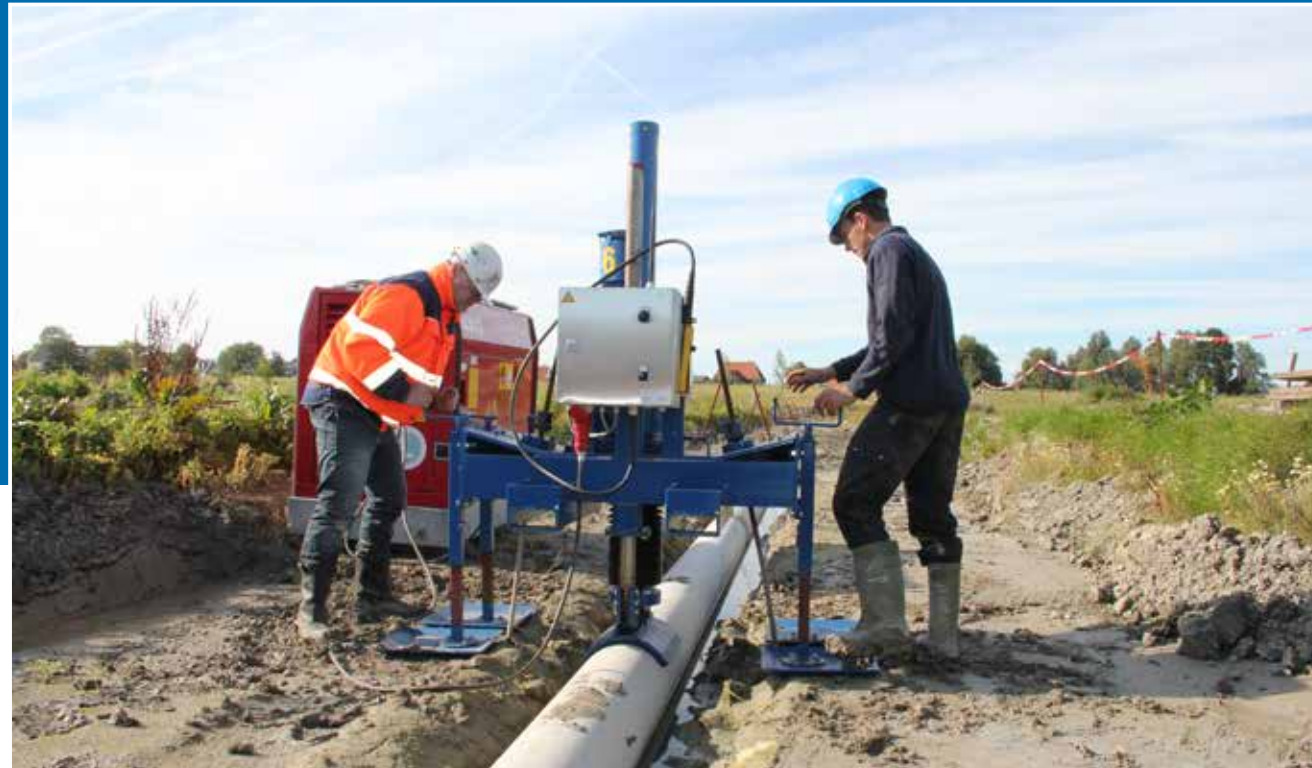
De pijpleiding wordt op een gecontroleerde manier met licht materieel in de (zachte) grond gedrukt.
